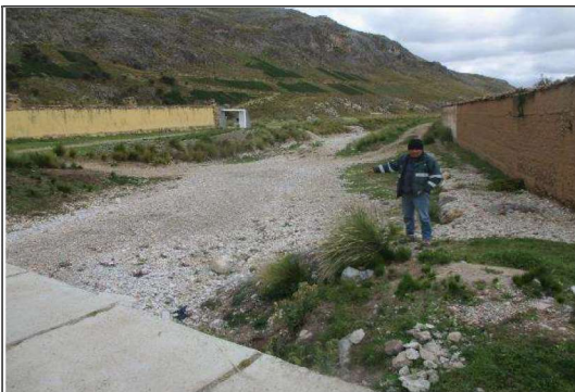
Fotografía 1: Quebrada Seca colmatada, construcción de casa en las riveras, sector Ninacaca.
