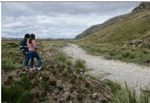
Fotografía 2: Quebrada Seca, colmatación y erosión de la ribera ambos márgenes, en el cauce posible desborde.
